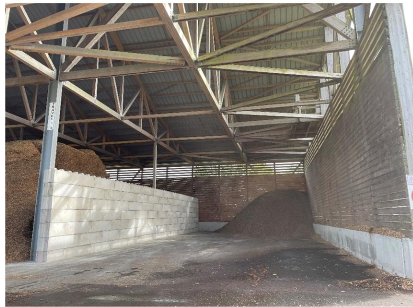
Plateforme de Buhulien : mis en place de plot de séparation
